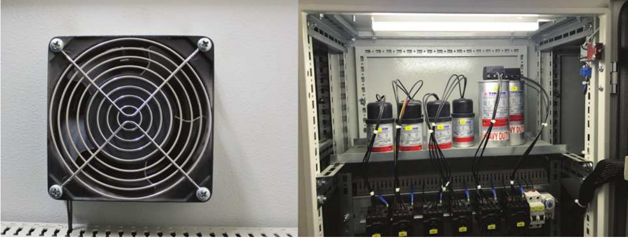
Görsel 11.11: Kompanzasyon panolarında aydınlatma ve havalandırma
