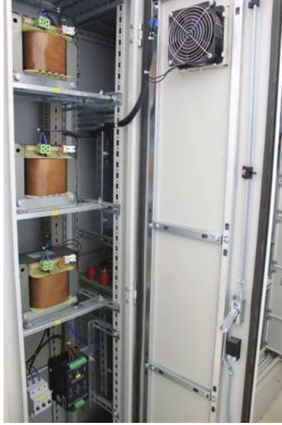
Görsel 11.8: Kompanzasyon panolarında reaktörler ve reaktör sürücüsü
