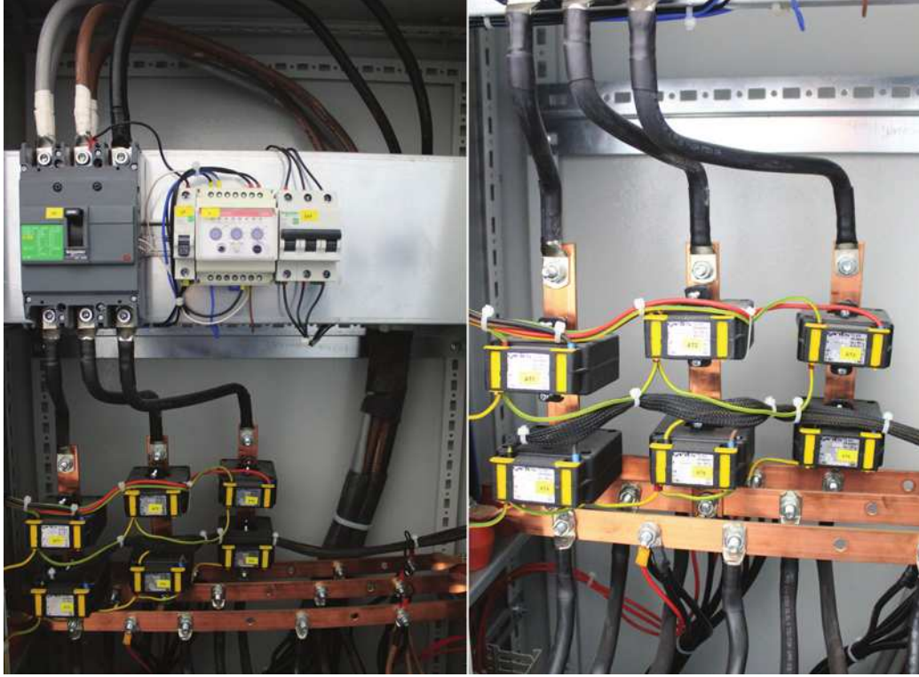
Görsel 11.10: Kompanzasyon panolarında akım trafolarının montajı
